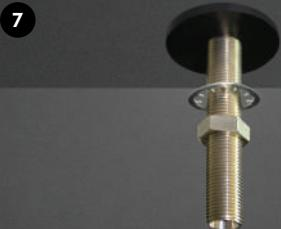
7 Наденьте на кран пластмассовую шайбу, стопорную шайбу и гайку.
