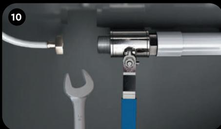
10 Пользуясь рожковым ключом на 24 мм, отсоедините шланг холодной воды от крана.
