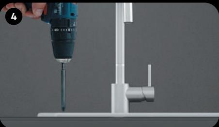
Просверлите отверстие под кран чистой воды при помощи сверла диаметром 12 мм.
